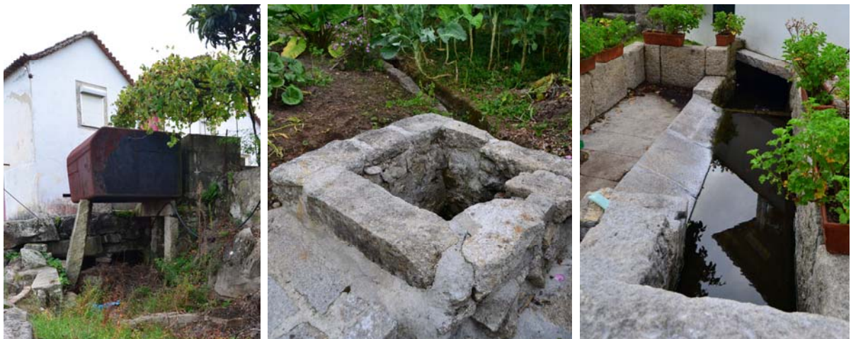
18 a 20. Sistema de encaminhamento da água (para o moinho e rega) dentro de um lugar de lavrador; "caixa" de distribuição e lavadouro. Fotos da autora, 2013.
