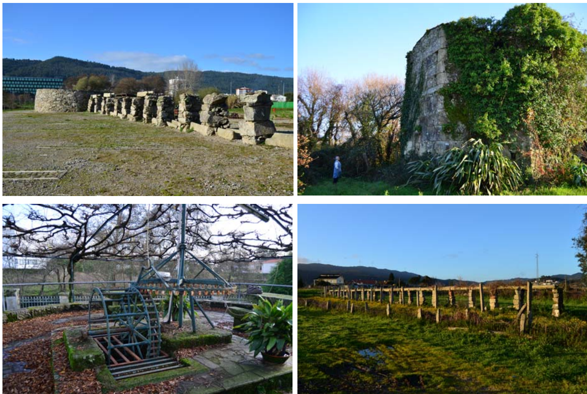
14 a 17. Estanca-rios: estrutura em granito, na Argaçosa. Estanca-rios dentro de torre, nos Matos; Mecanismo em ferro, em Portuzelo; e aqueduto, na Linha do Vale do Lima. Fotos da autora, 2013.
